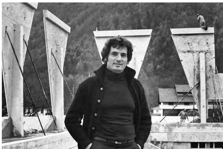
Costruzione della Fondation Pierre Gianadda, 1978.
